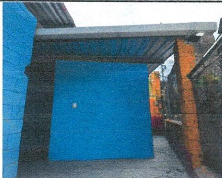
Foto 1 La imagen nos muestra la finalización de los trabajos como lo es la entrada hacia los sanitarios
